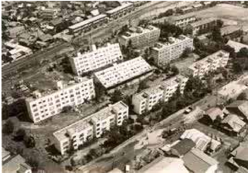
液状化した地盤と川岸町県営アパート
