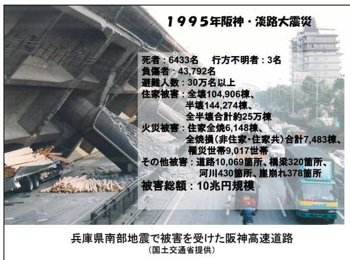
図1 阪神・淡路大震災の被害状況
